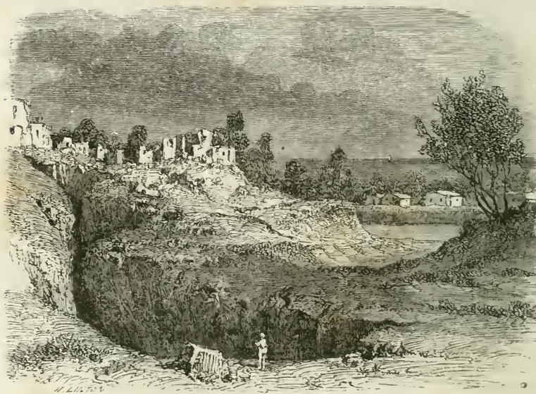
Fig. 91. Fissure près de Polistena.
